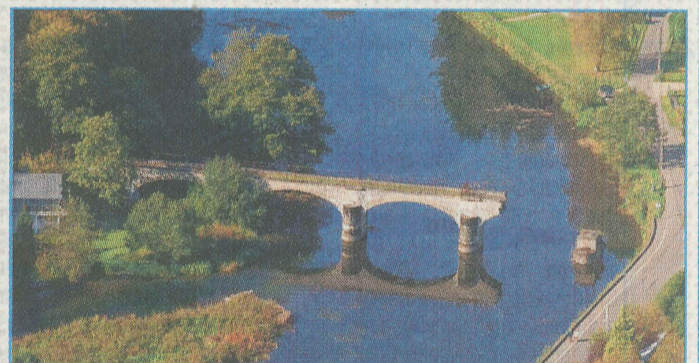
Le pont-cassé de Bohan a été détruit en 1940. Une structure en bois a permis son fonctionnement jusqu'en 1944.
